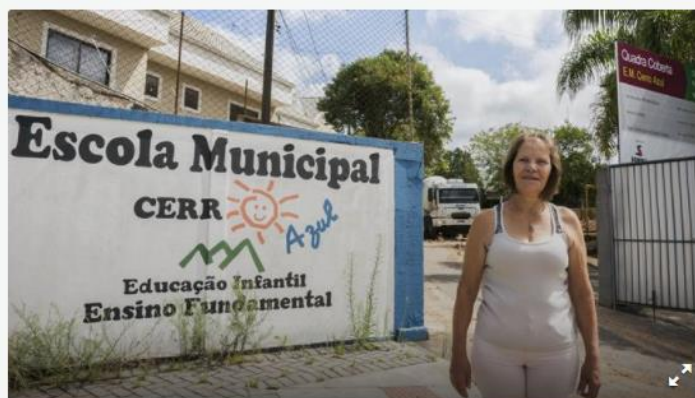
Ano começa com a construção de quadra coberta em escola e cinco
