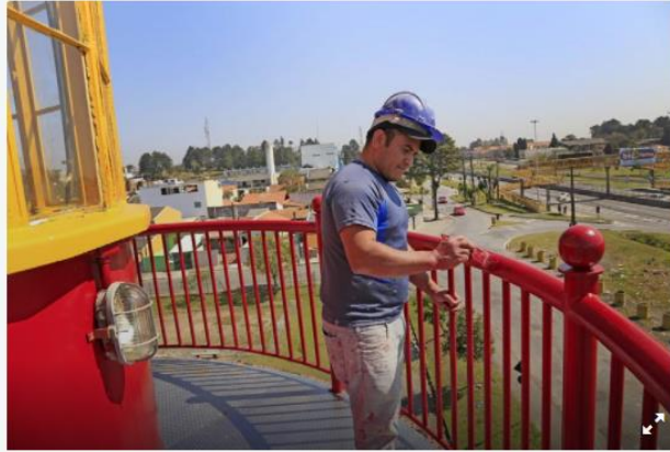
Obra de reforma do Farol do Saber Herbert José de Souza, no bairro Uberaba. Curitiba, 29/08/2017 Foto:Luiz Costa/SMCS
